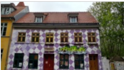
Der aktuelle Zustand des „Pariser“
